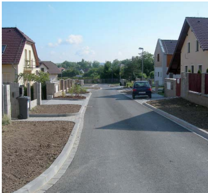
Úsek nově vybudované komunikace v obci Bděňves.
