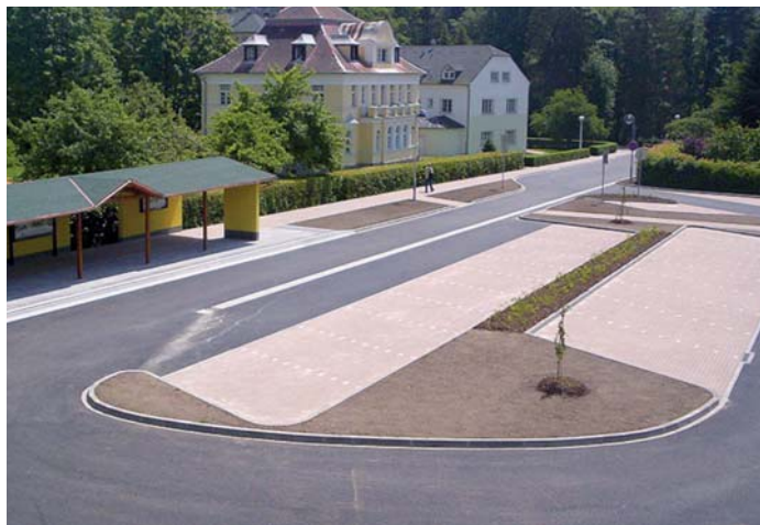
Nově vybudovaný autobusový terminál
